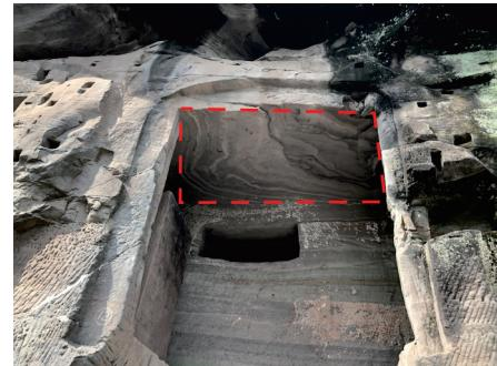
图3 安岳圆觉洞12号窟顶板沿层理面发生剥落
