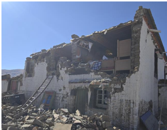
图2 典型两层土木结构(拉孜县查务乡)
