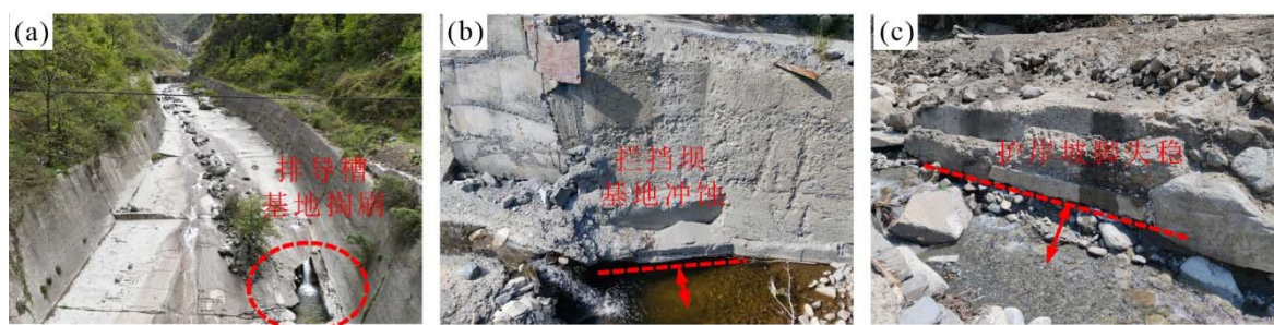
图 4 防护工程结构冲刷掏空破坏
