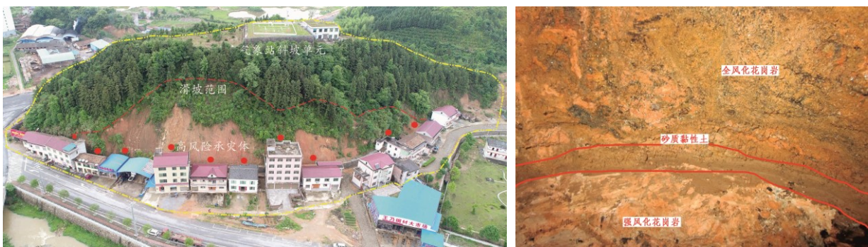
c. 县气象站滑坡与典型切坡建房例； d. 大院农场滑坡揭露的滑带层砂质黏性土
