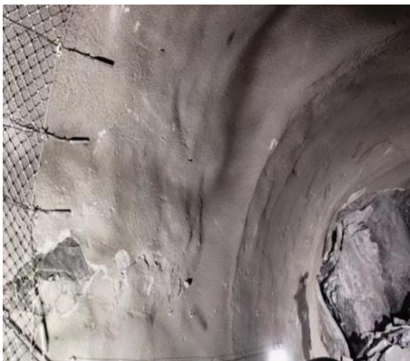
(b) 强烈岩爆导致处置开裂剥落掉块
