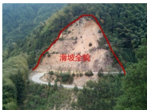
图5-2 全风化凝灰岩滑坡
