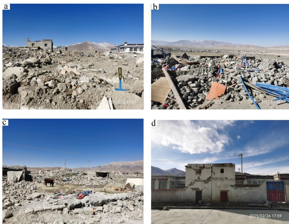
图3 定日地震对不同村庄房屋破坏影响照片
