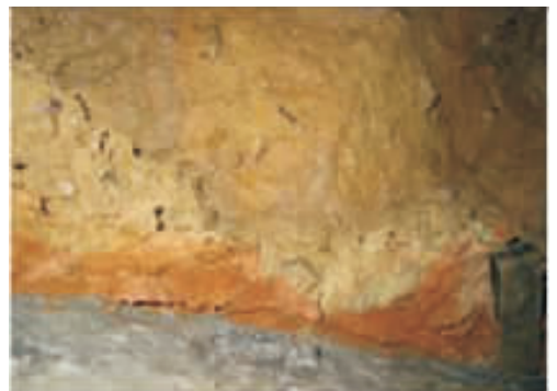
图 3 TP3 平硐硐顶蠕滑面剪出特征
