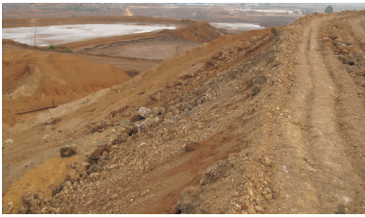
图 6 平乐二塘锰矿区典型填土边坡
