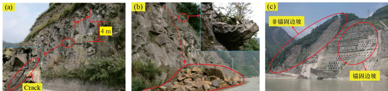
图1 汶川大地震后震区典型锚固边坡抗震效果
